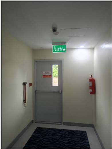
อุปกรณ์ป้องกันอัคคีภัย ไฟส่องสว่างฉุกเฉิน และตู้หัวฉีดน้ำดับเพลิง (FHC)
