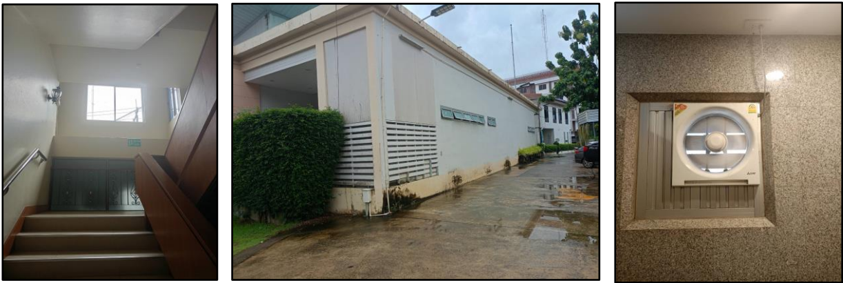
ช่องเปิดระบายอากาศและระบายความร้อนในอาคาร
