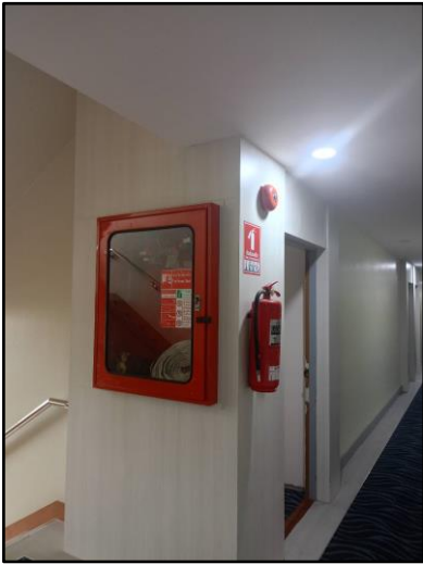
อุปกรณ์ป้องกันอัคคีภัย ไฟส่องสว่างฉุกเฉิน และตู้หัวฉีดน้ำดับเพลิง (FHC)
