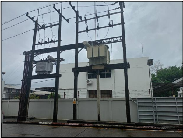
หม้อแปลงไฟฟ้า พร้อมติดตั้งป้ายเตือน “อันตรายไฟฟ้าแรงดันสูง”
